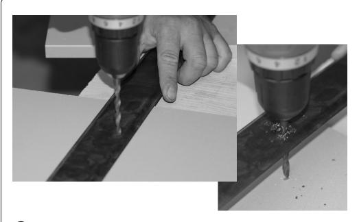
Прикладываем молдинг обратно на старое место не защелкивая, наживляем болты 6х80 проверяя, точно ли совпали отверстия.
